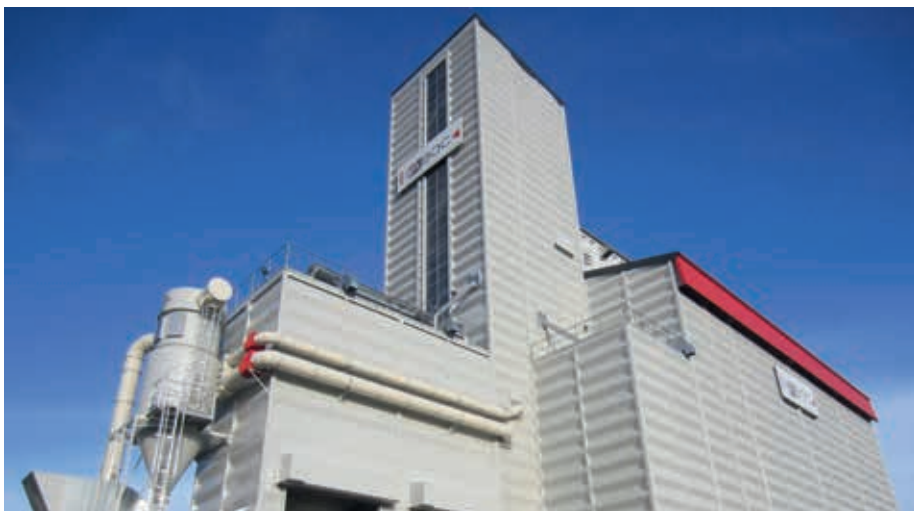
→ La société Saboc a pris l'option d'un silo dont l'enveloppe et les cellules sont construites en palplanches.
